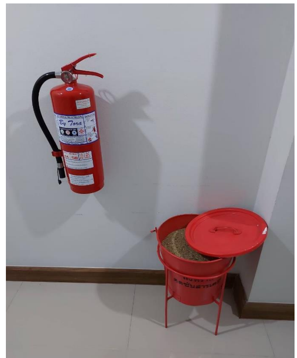
ภาพถ่ายรวมอุปกรณ์ (ถังทราย/ วัสดุดับสารเคมี/ ถังดับเพลิง)
