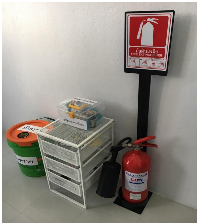
ภาพถ่ายรวมอุปกรณ์ (ถังทราย/ วัสดุดับสารเคมี/ ถังดับเพลิง)
