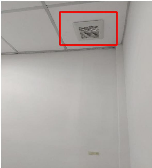
ภาพถ่ายพัดลมระบายอากาศภายในห้องเก็บรักษาเครื่องสำอาง
